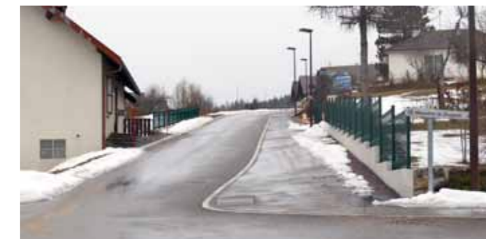
Le choix s'est porté sur des trottoirs au ras de la chaussée pour faciliter l'accès piétons mais aussi et surtout le déneigement.
