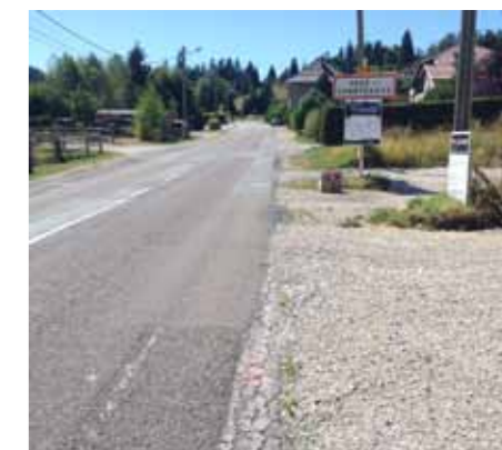
Le choix s'est porté sur des trottoirs au ras de la chaussée pour faciliter l'accès piétons mais aussi et surtout le déneigement.
